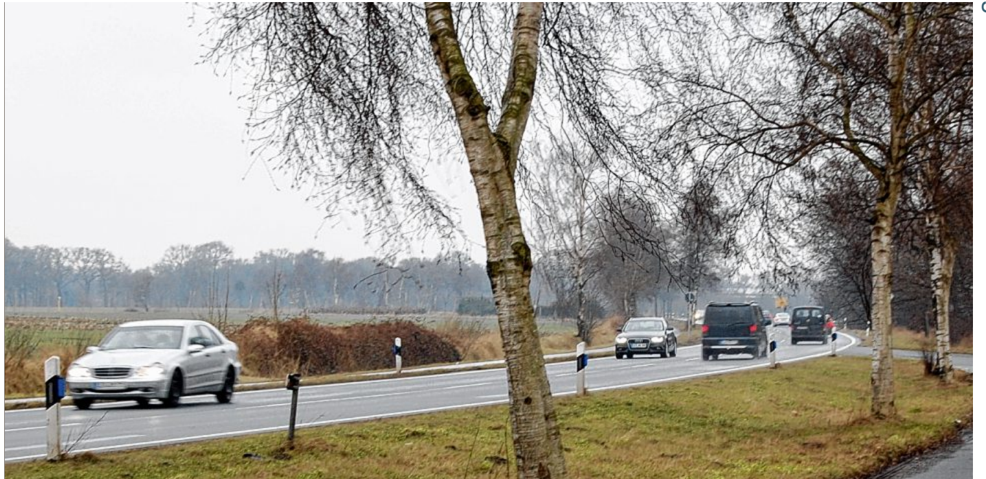
Die Bundesstraße 436 zwischen Holtland und Brinkum ist eine viel befahrene Strecke. Sie soll ausgebessert werden, teilt die Straßenbaubehörde in Aurich mit.
